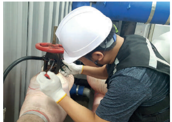
▲ 소방 전기 공사
