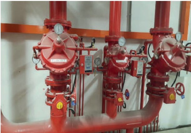
▲ 소방 기계 설비 공사
